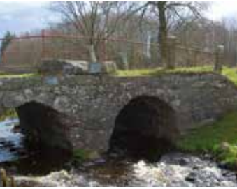
Brücke von Bommerlund
